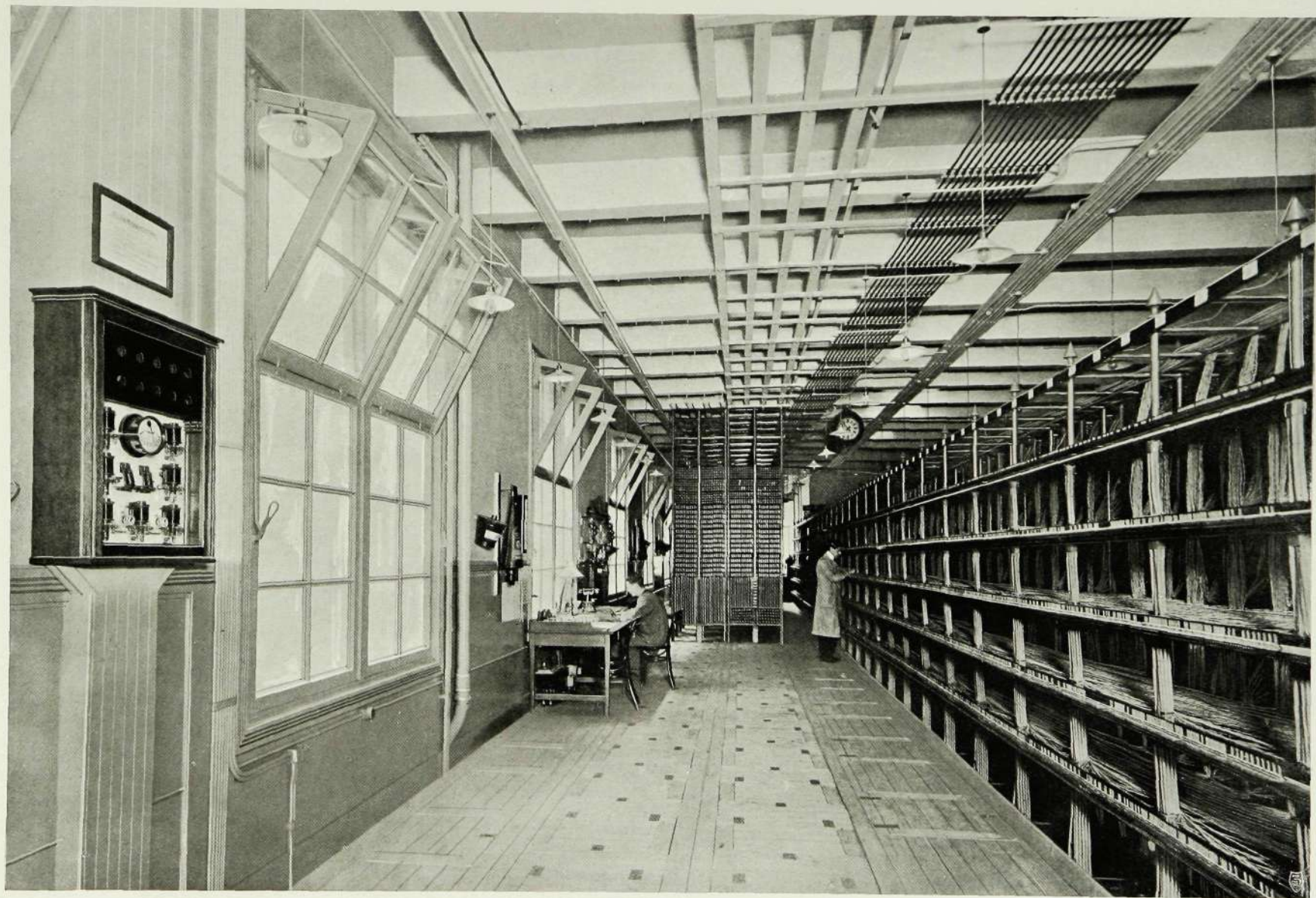
Telefonstationen i Rotterdam. Korskopplingsalen
