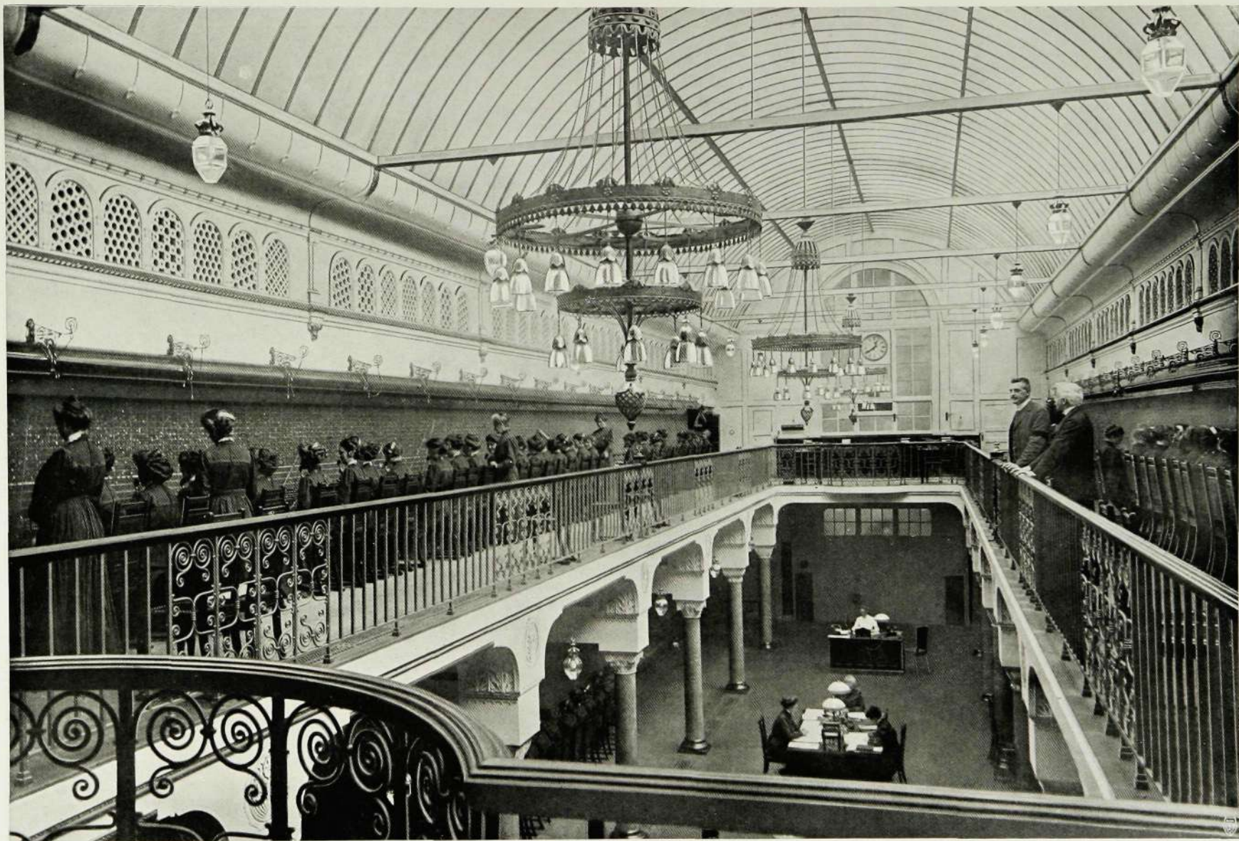
Telefonstationen i Köpenhamn
